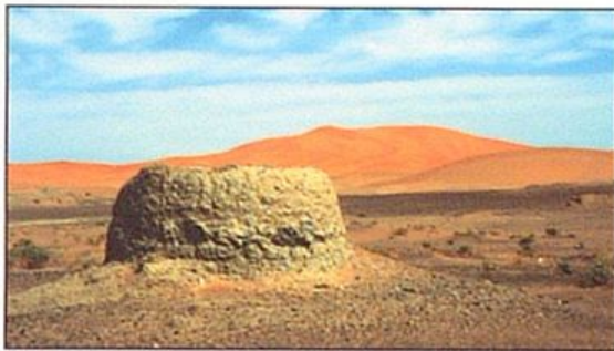
A4 Khettara dans la région pré-saharienne de Merzouga. Ces canalisations souterraines très anciennes drainent l'eau vers les villes en la protégeant du soleil et de l'évaporation.
