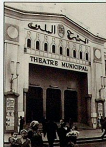
166 Le Théâtre municipal de Casablanca, avant sa démolition
