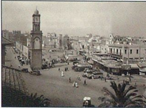
160 Tour de l'Horloge de la porte Bab al-Souk à Casablanca, édifée par le commandant Dessigny sur ordre du général Drude (1907-1908)
