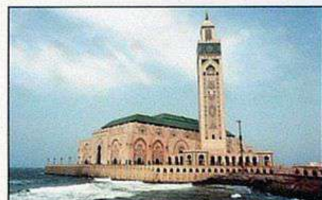
323 La Mosquée Hassan II à Casablanca
